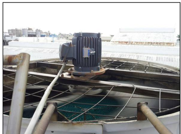
圖 16 新循環水冷卻風扇馬達
