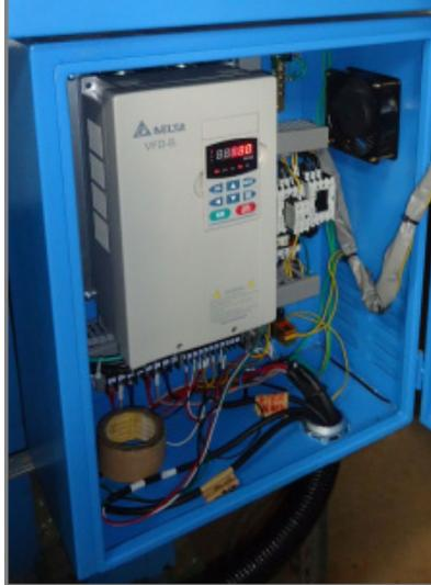
圖 17 冷卻風扇變頻控制器
