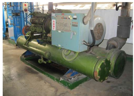
圖 13 C 公司 No1 冰水系統
