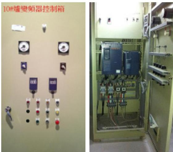
圖 6 10 號窯爐 30 hp、50 hp 風車系統變頻箱
