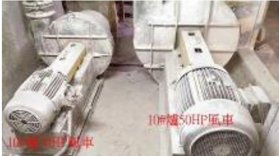
圖 4 10 號窯爐風車系統
