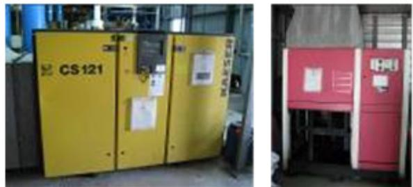
圖 7 B 公司空壓系統空壓機(左：100 hp，右：75 hp)
