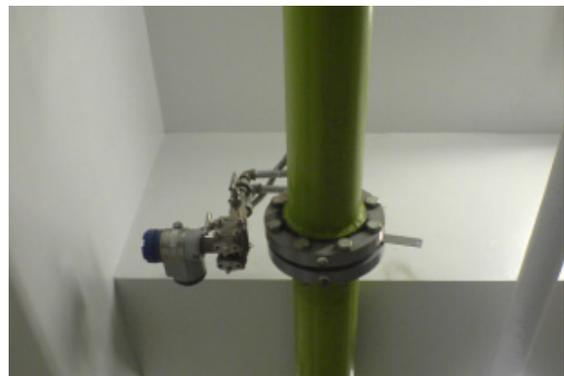
圖九 差壓式流量計安裝實例
