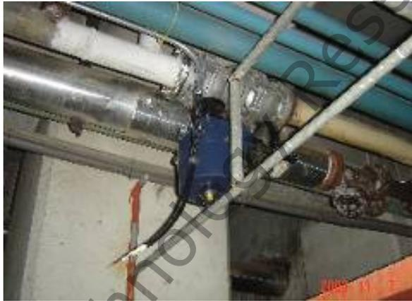
圖十一、新裝電動切斷閥
