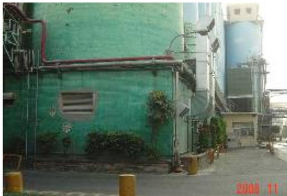
圖九、改善後空壓機房新增進風孔與排風管
